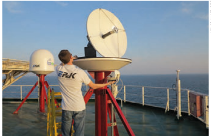
Ein größerer Antennenreflektor ermöglicht eine bessere Empfangsqualität
